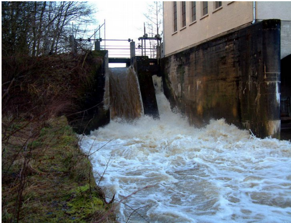
Canal of power unit Fa. Leipa Schrobenhausen Foto: Schwäricke (2002)
