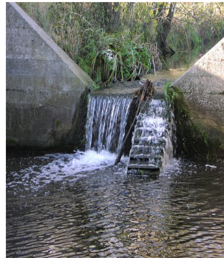
„Fish-Stairs“ in Mittelfranken, Foto: Schwäricke (2009)
